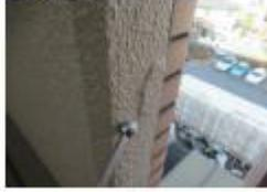
爆裂② (鉄筋露出)
