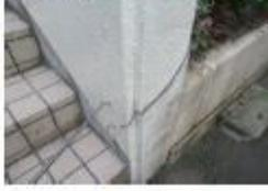
爆裂② (鉄筋露出)
